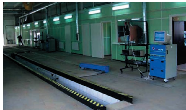
Монтаж и пуско-наладка
